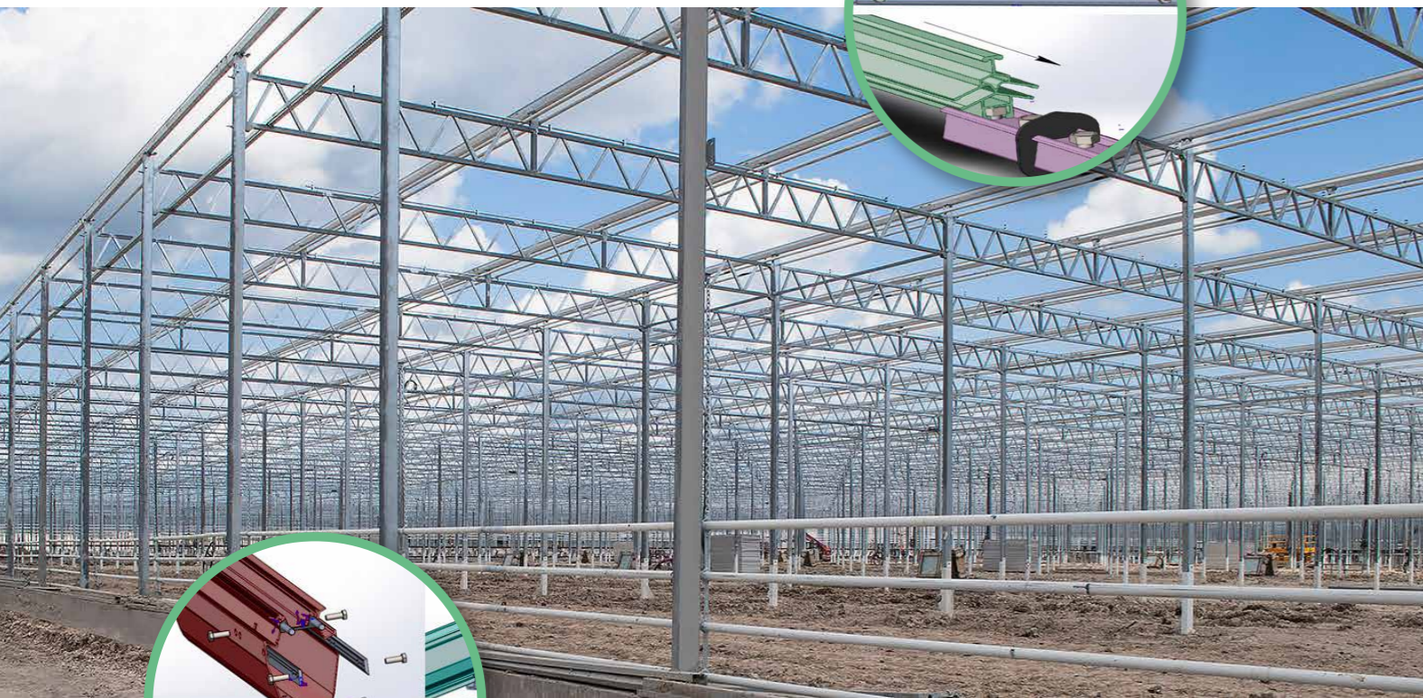
Стальные конструкции (сталь С255, 09Г2, сварка дуговая в защитных газах, горячее цинкование 80-100мкм)
